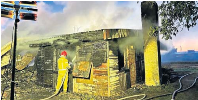
Budynek gospodarczy uległ spaleniu
