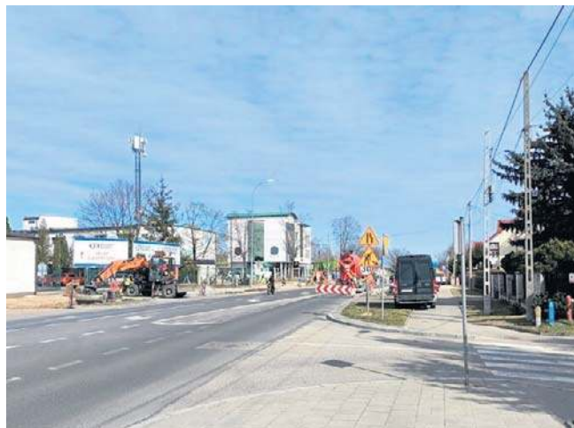
Przez remonty na ul. Baranowickiej nie ma miejsca na bezpieczne przejście - uważa nasz Czytelnik
