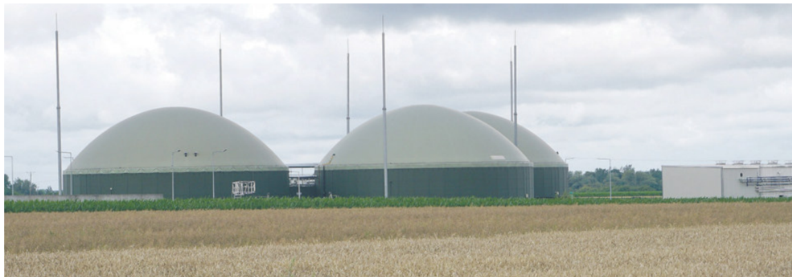
Biogazownia w Rowiskach ma mieć moc dwa razy większą niż ta między Zawadami a Żelazowem. fot. sej
