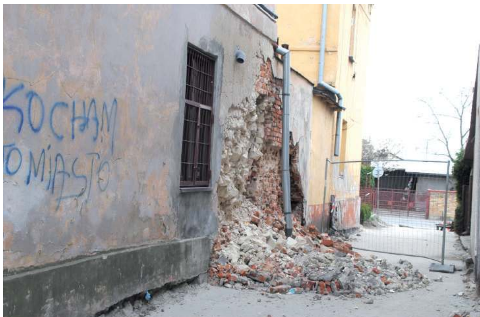
29 marca, w trakcie prac związanych z naprawą ubytków tynku, odspoił się fragment ściany budynku Wspólnoty Mieszkaniowej Stary Rynek 44 w Opolu Lubelskim. Uszkodzeniu uległ fragment na długości około 2,5 m i szerokości około 20 cm
