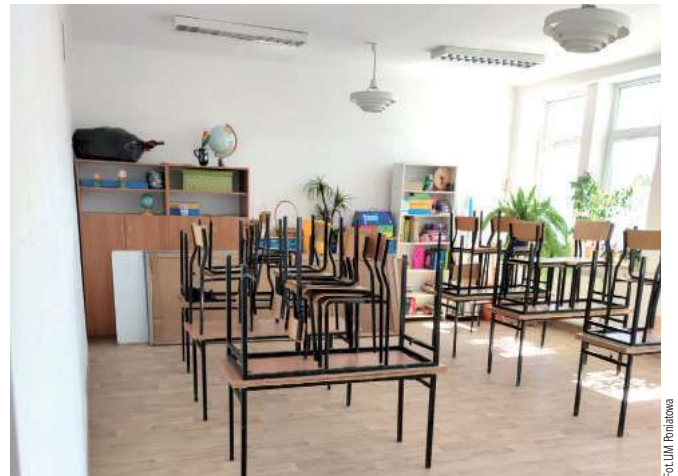
W salach lekcyjnych wymieniane były podłogi, drzwi, punktowo instalacja elektryczna, kładzione tynki, malowane ściany i remontowane parapety
