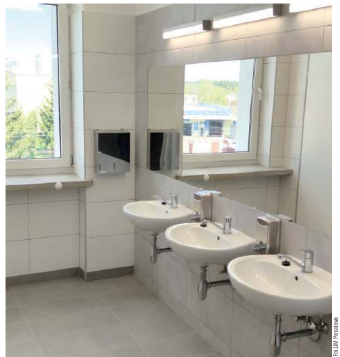
Wszystkie pomieszczenia przeszły kompleksowy remont. Dostosowane zostały też do obowiązujących przepisów przeciwpożarowych oraz do potrzeb osób niepełnosprawnych. Przebudową objęte były również łazienki
