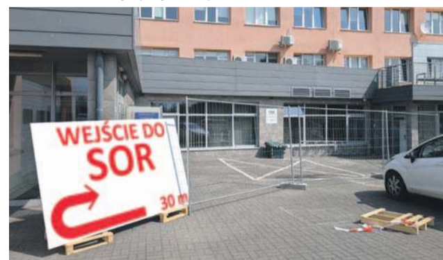
Nie da się ukryć, że trwa przebudowa
