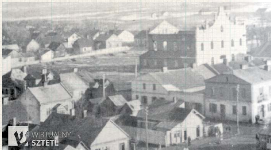
Panorama Żelechowa z będącą dominującym elementem krajobrazu budynkiem synagogi. Zdjęcie wykonane zaraz po wojnie: widzimy, że budynek nie posiada już dachu zniszczonego przez Niemców, nie ma też macew na cmentarzu. Niedługo potem mury zostały rozebrane
