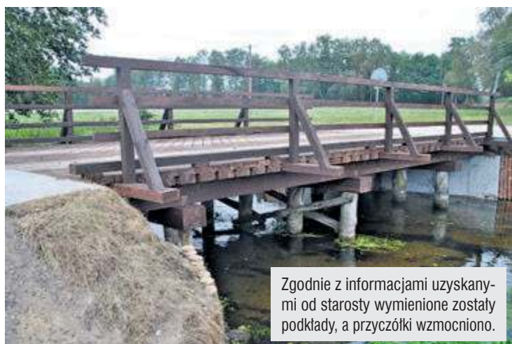
Przejazd przez most jest teraz bezpieczny.
