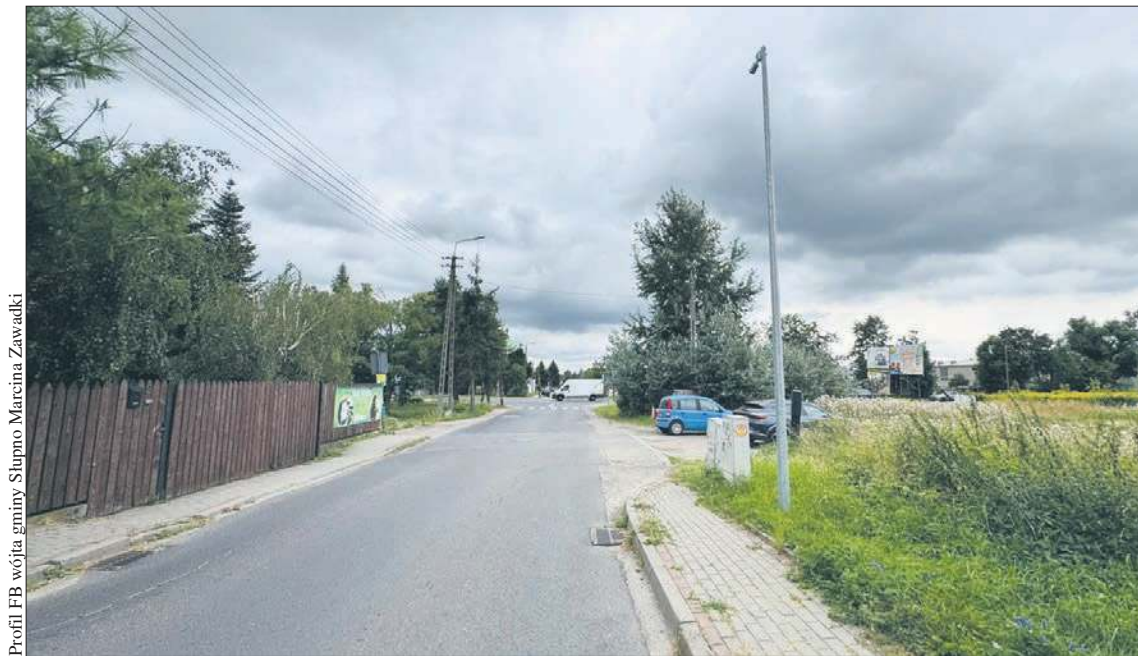
W Nowym Gulczewie trwa rozbudowa systemu monitoringu wizyjnego ulic
