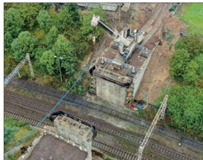
Przebudowa wiaduktu wzdłuż ul. Mariackiej w Radlinie ma pochłonąć około 5 mln zł, z czego 1,5 mln to dofinansowanie z Rządowego Funduszu Inwestycji Lokalnych
