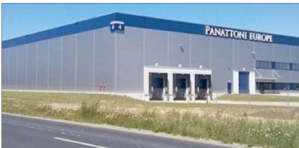
Panattoni specjalizuje się w budowie ogromnych hal magazynowych
