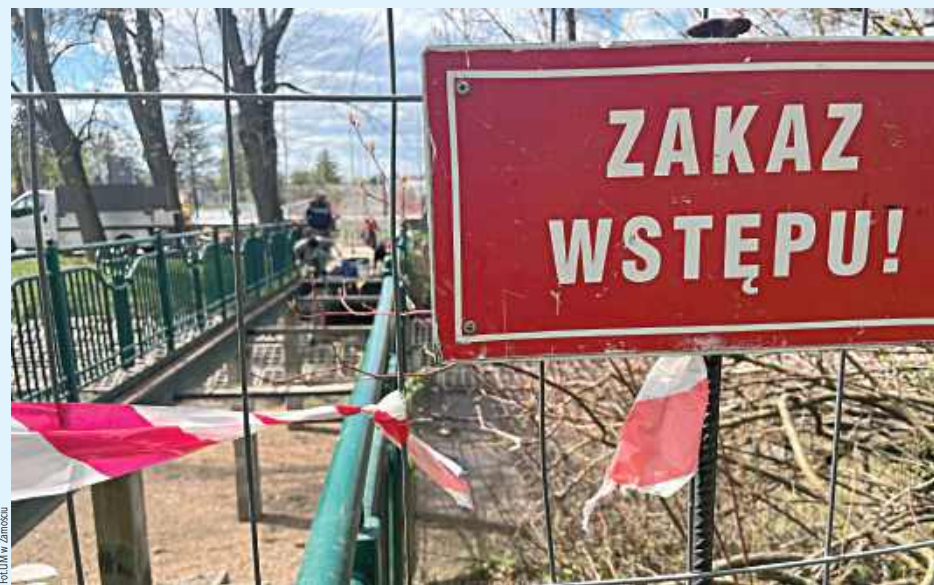
W Parku Miejskim w Zamościu trwa remont jednego z mostków nad stawem
