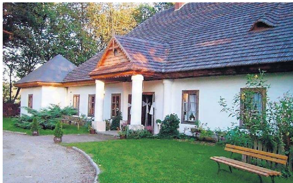
Dwór w Świdniku. Cenny zabytek stanowi typowy przykład budownictwa dworskiego i ciągle dopomina się remontu
