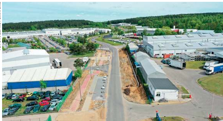
Tegoroczną sztandarową inwestycją powiatu jest przebudowa ul. Nowej w Mławie - drogi dojazdowej do dzielnicy przemysłowej. Koszt: 16,3 mln zł
