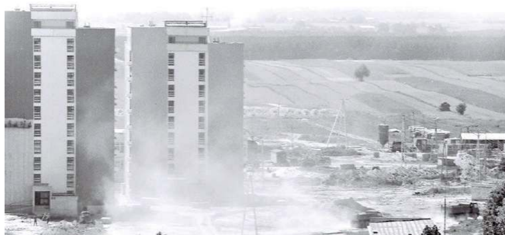
Osiedle Niepodległości. Wieżowce przy - obecnie - Armii Krajowej
