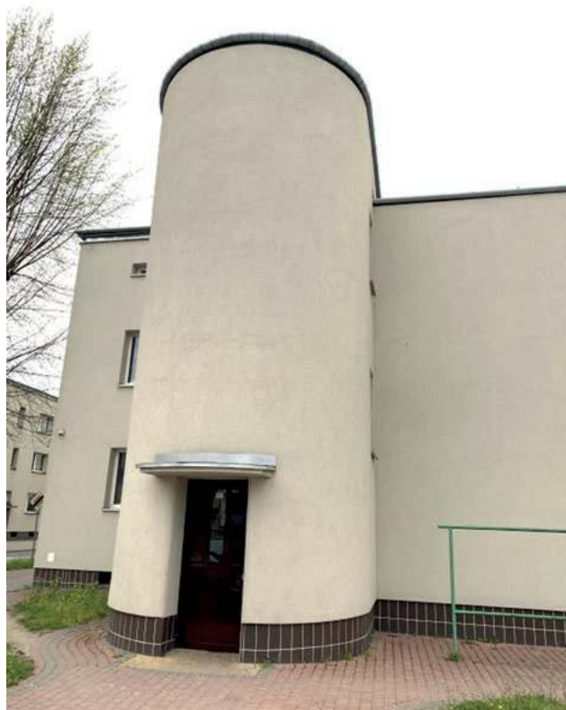
Okrętowa część bloku, przez którą prowadzi klatka schodowa. Archiwum prywatne autora
