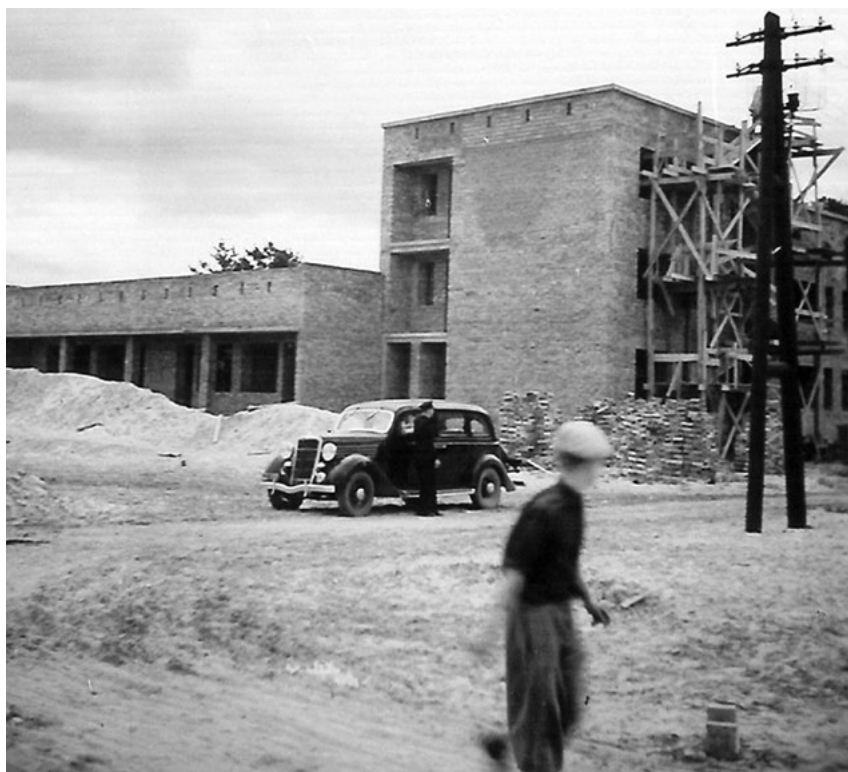
Budowa bloku, lipiec 1938 r. Ze zbiorów Muzeum Regionalnego w Stalowej Woli
