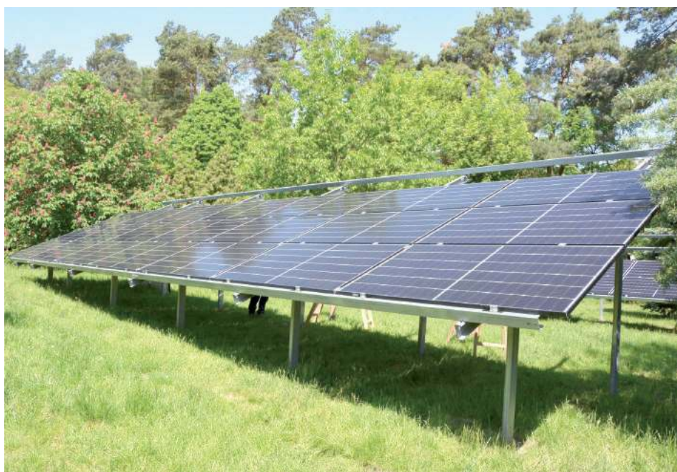
W Puchaczowie ruszył montaż paneli fotowoltaicznych na budynkach użyteczności publicznej
