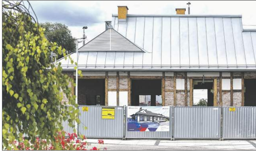
W 2023 r. rozpoczęła się przebudowa budynku zabytkowego dworca PKP w Pilawie
