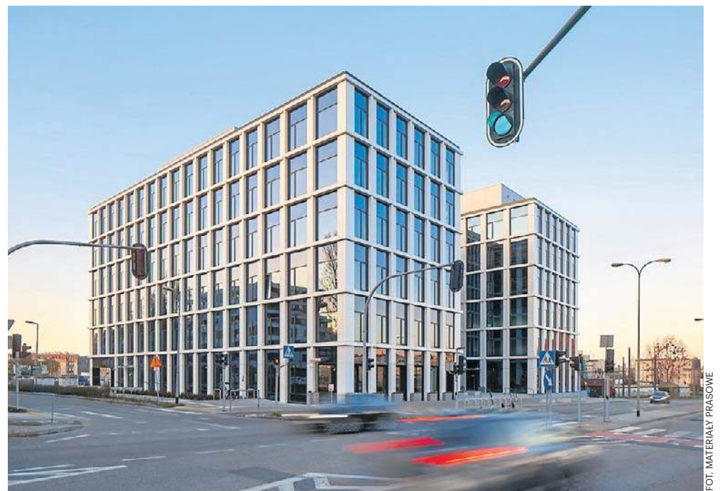
Na całym najwyższym piętrze K2 rozlokowała się firma logistyczna ATC Cargo
