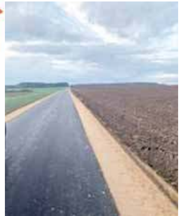
Fragment zmodernizowanej drogi Bogurzynek – Mdzewo
