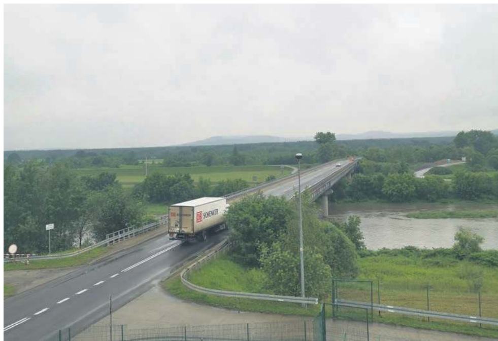
Widok na most w Jankowicach
