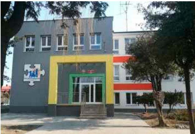
Ocieplona, odnowiona i kolorowa. Tak wygląda SPS nr 26 po modernizacji
