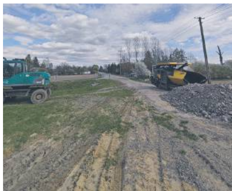
Wola Siennicka - przebudowa drogi -
