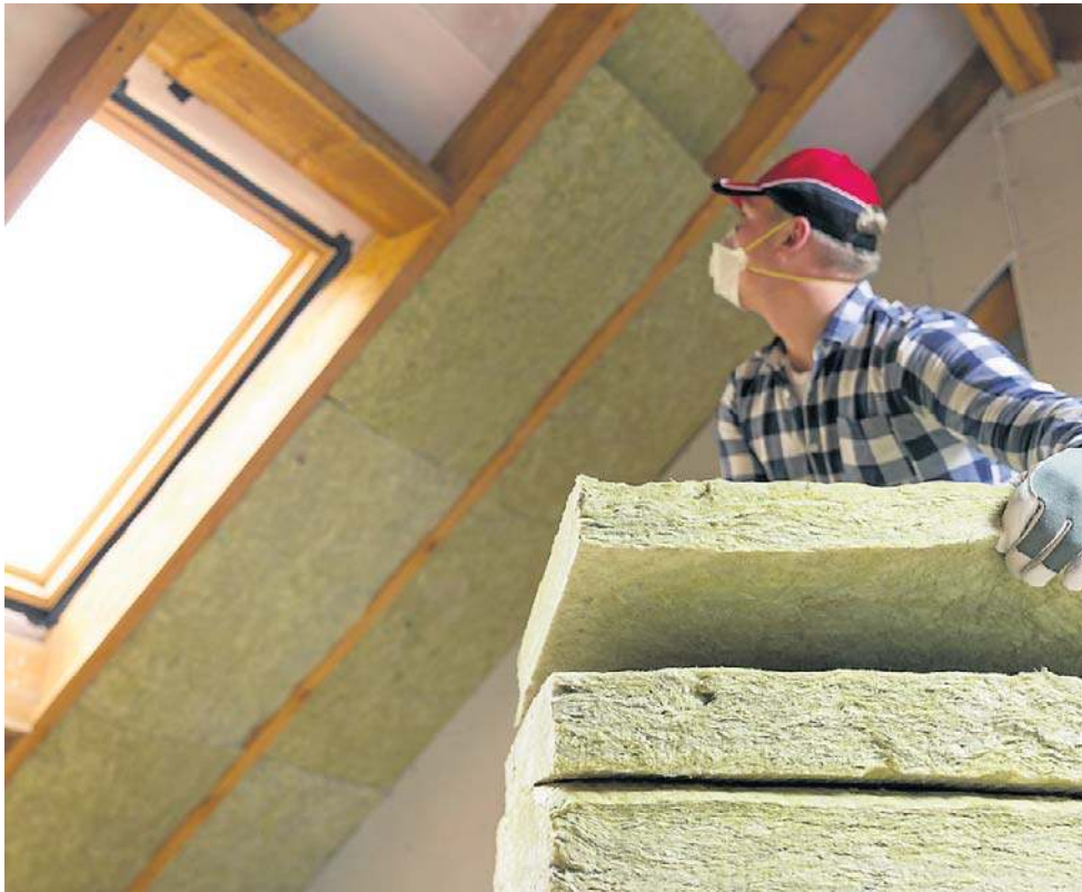
W budynkach bezemisyjnych nie będzie można stosować źródeł ciepła, chłodu i energii elektrycznej emitujących na miejscu dwutlenek węgla z paliw kopalnych
