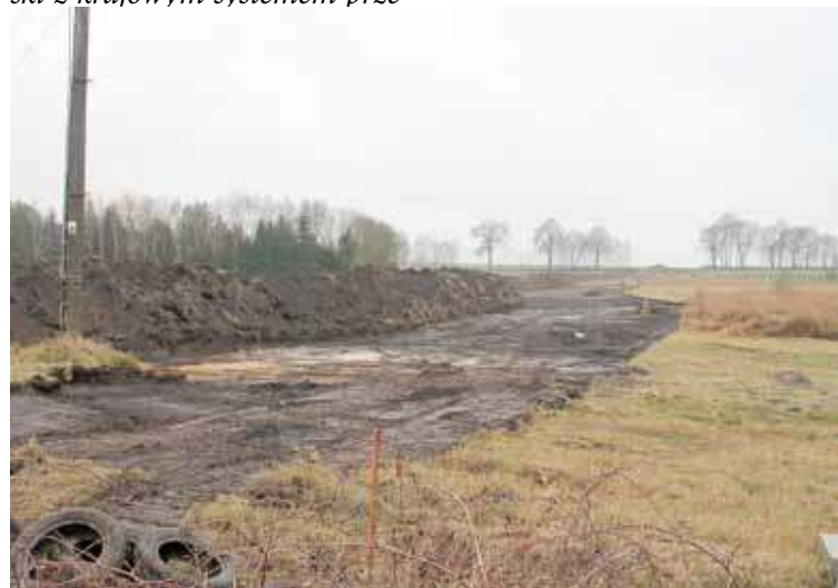
Prace ziemne w pobliżu Kulic przy budowie gazociągu Szczecin-Gdańsk
