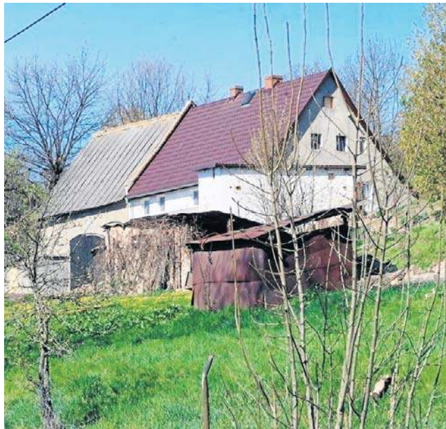
Ostatnie zabudowania wsi Rzymówka. Wody Polskie przejęły tereny pod budowę zbiornika
