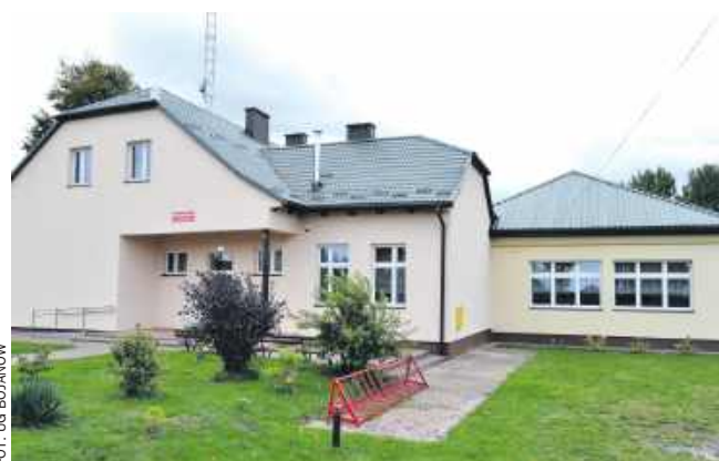
Jedną z placówek, która przeszła modernizację jest Publiczna Szkoła Podstawowa w Gwoźdźcu
