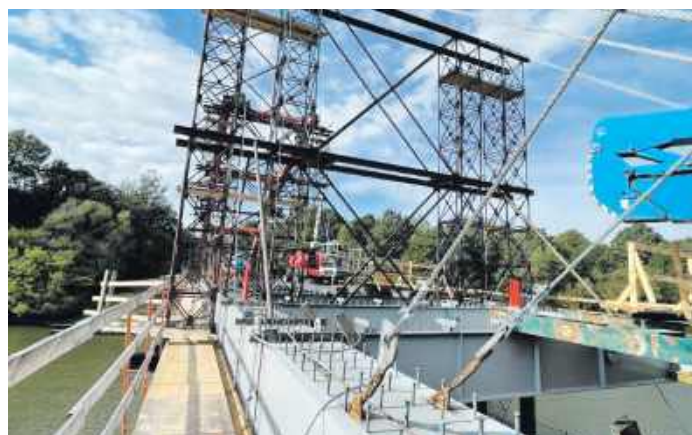
Prace przy budowie mostu postępują zgodnie z planem
