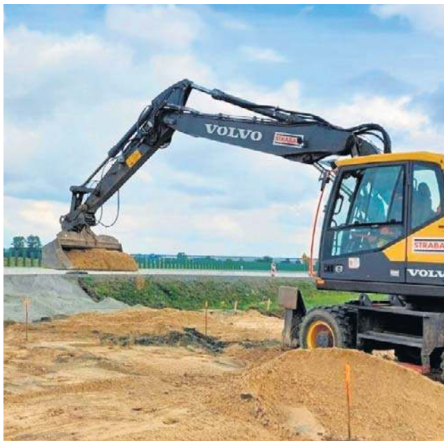
Na placu budowy pojawił się już ciężki sprzęt
