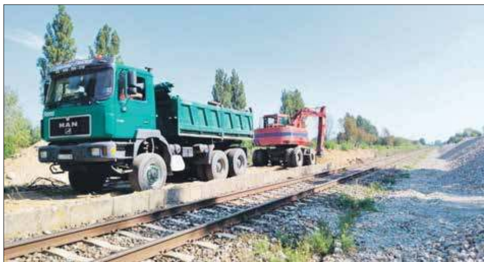
Wykonawca rozebrał perony, m.in. na przystanku w Tarle
