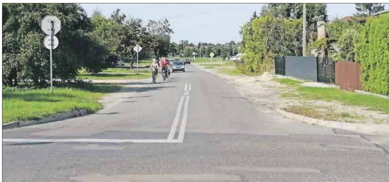
Ulica Daleka ma być modernizowana, gdyż weźmie na siebie ciężar ruchu komunikacyjnego związanego z wjazdem i wyjazdem z osiedla. Chodnika jednak w ramach inwestycji nie przewidziano
