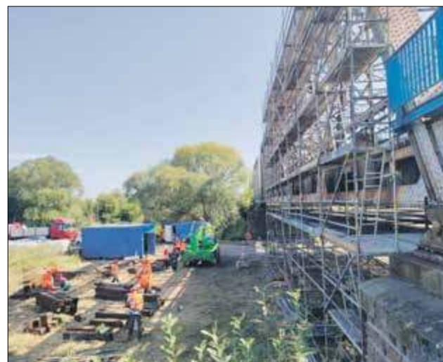
Trwają intensywne prace na moście na rzece Wieprz
