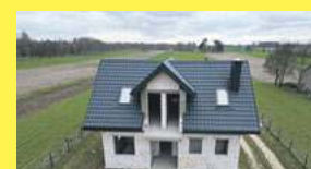
Dom w stanie surowym otwartym, Wólka Siemieńska, 885 851 160
