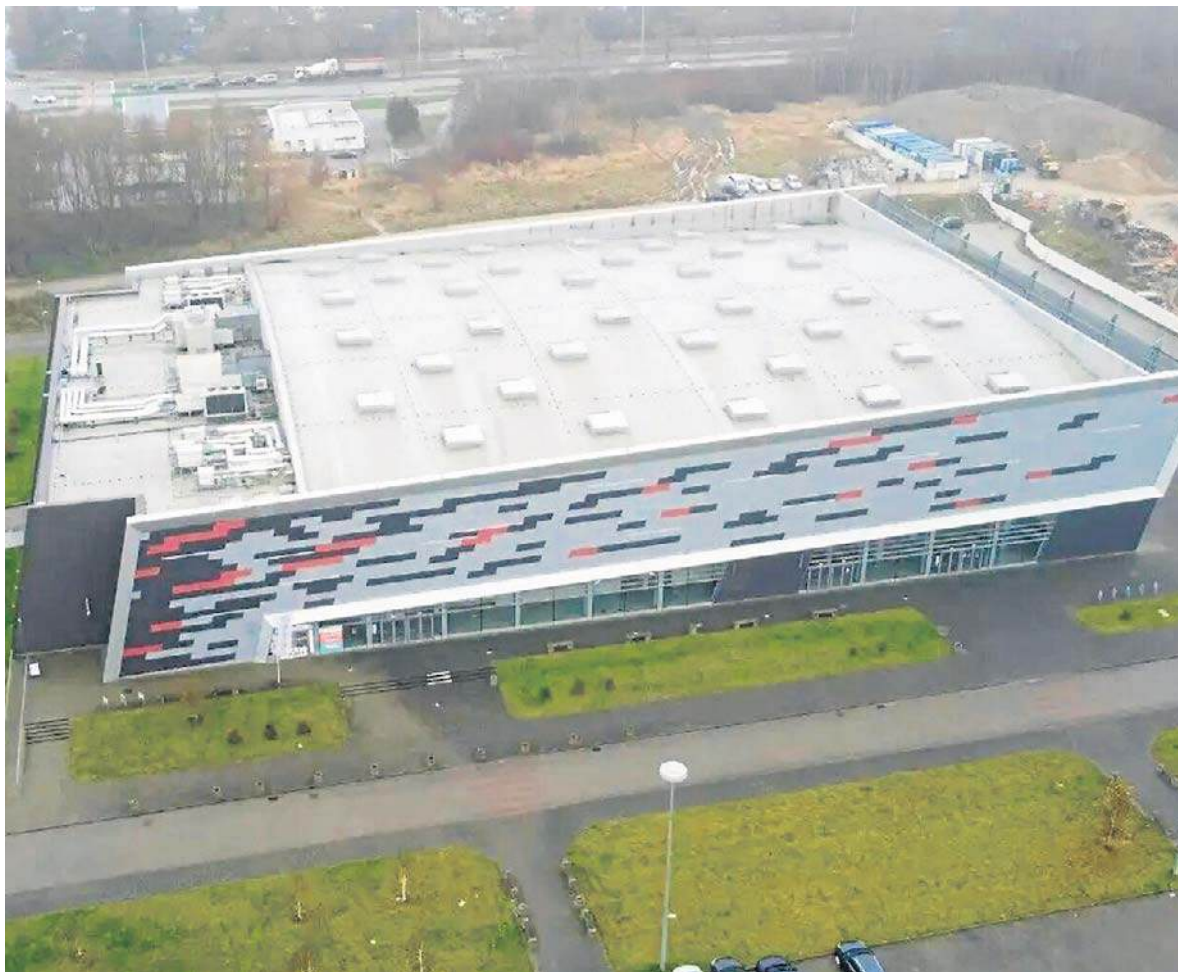
Hala widowiskowo-sportowa przy ulicy Śniadeckich w Koszalinie
