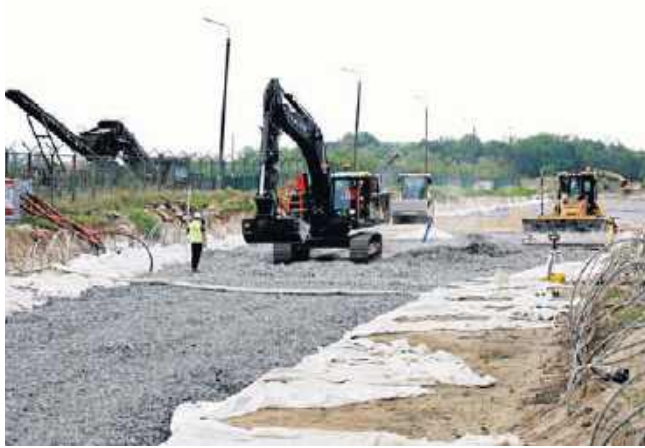
Trwa budowa linii kolejowej do portu w Policach
