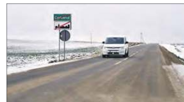
Droga w Czyżowicach przed i po remoncie
