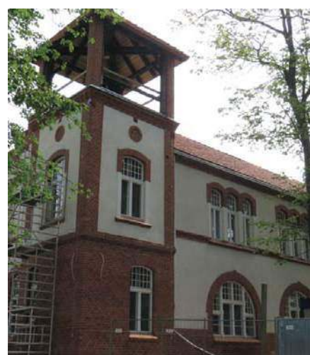
Remont budynku MOK
