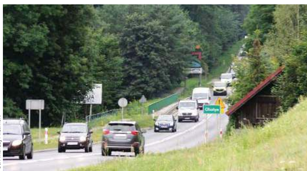
Budowa północnej obwodnicy Olsztyna obejmie też przebudowę drogi 51 przez Las Miejski
