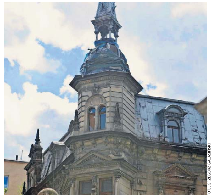
Willą Kellera z widoczną jeszcze narożną, stylową wieżyczką, która kilka lat temu w wyniku pożaru została uszkodzona, a później zdemontowana.
