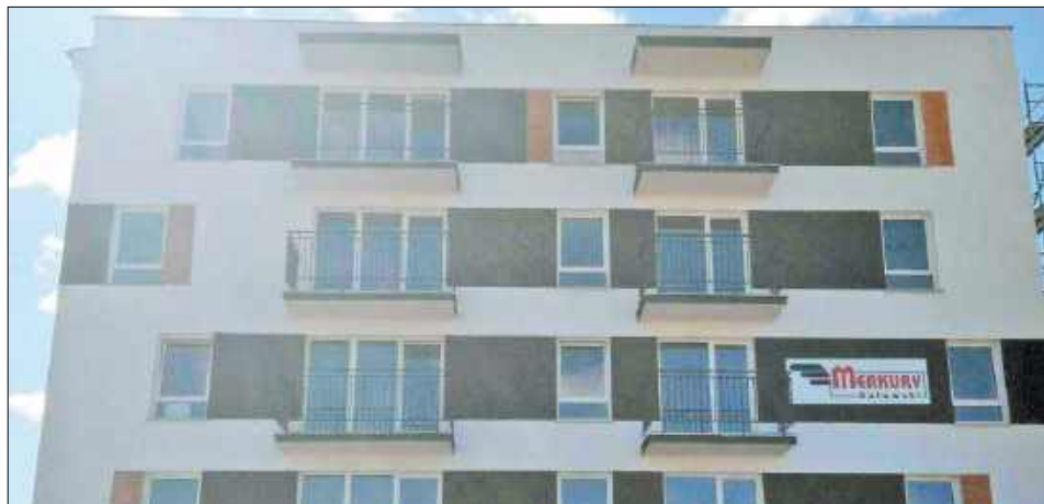
Cała inwestycja (pierwszy i drugi etap) obejmuje dwa czteropiętrowe bloki połączone ze sobą w parterze łącznikiem. Łącznie znajduje się tam ponad 200 mieszkań
