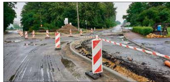
Przebudowa już się zaczęła.
