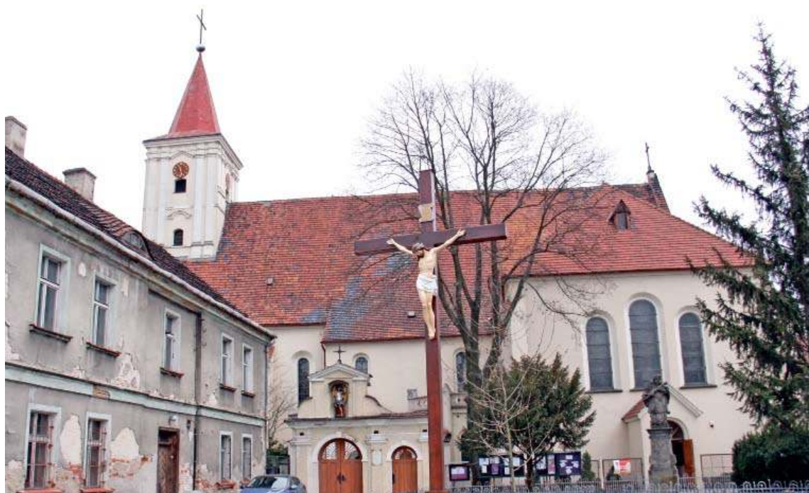
Kościół św. Michała Archanioła w Nowej Soli wymaga m.in. remontu dachu nawy głównej
