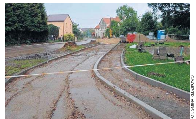
Budowa nowych ścieżek rowerowych w gminie Redzikowo
