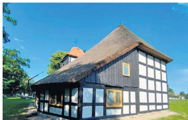
Kościół w Jasieniu pracach renowacyjnych
