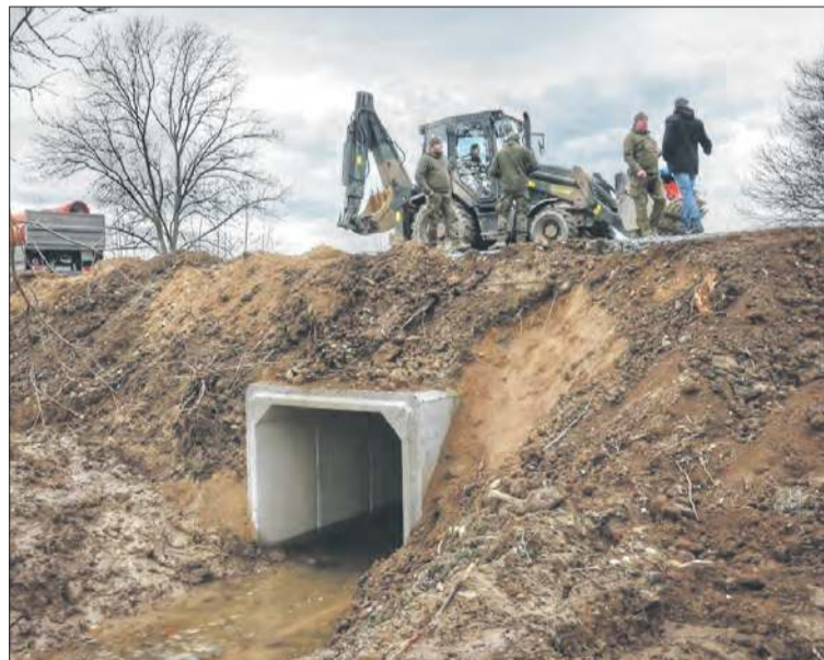
Zbudowana przez wojskowych konstrukcja ma charakter tymczasowy. Na ostateczny przepust lub most mieszkańcy i podróżni będą musieli poczekać.
