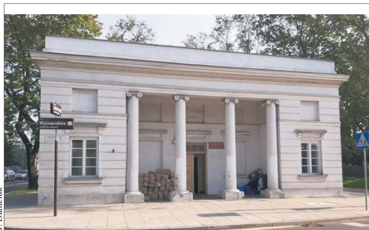
Jeden z budynków Rogatek Warszawskich, w którym znajduje się siedziba filii nr 2 Książnicy Płockiej zostanie wyremontowany
