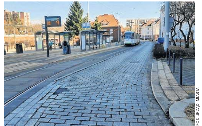
Remont nawierzchni potrwa do września
