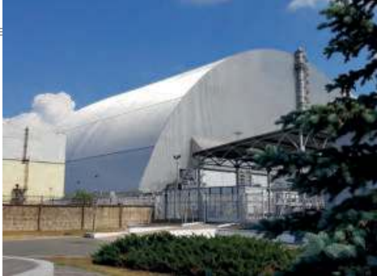
Nowy sarkofag nad zniszczonym reaktorem atomowym
