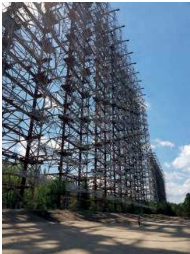
Konstrukcje radarowe Duga
