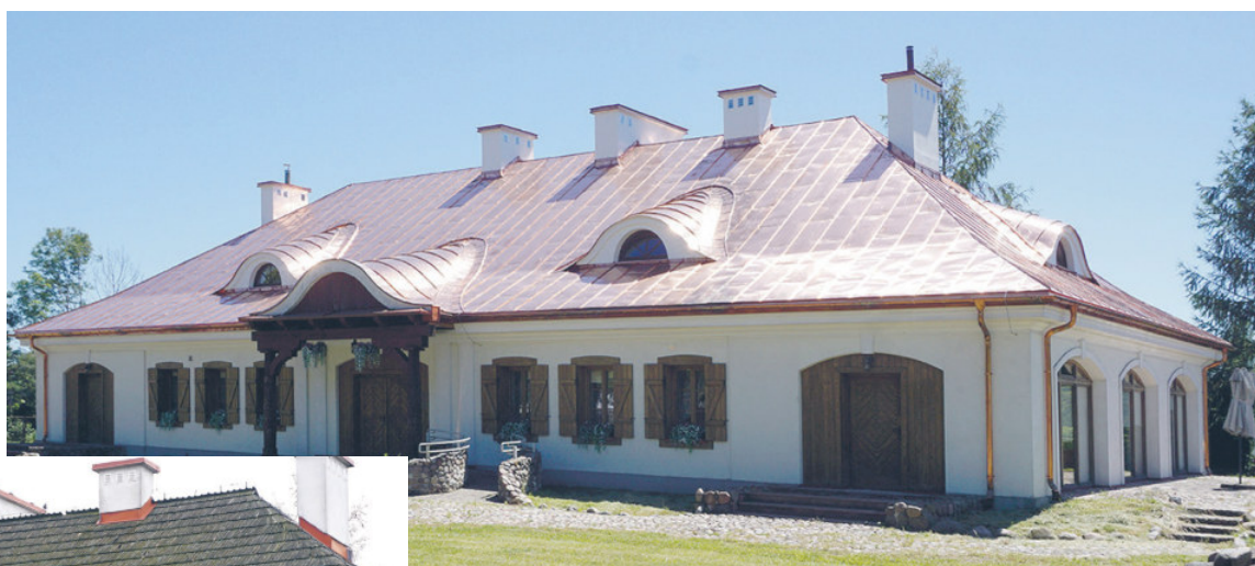
Zajazd po remoncie
