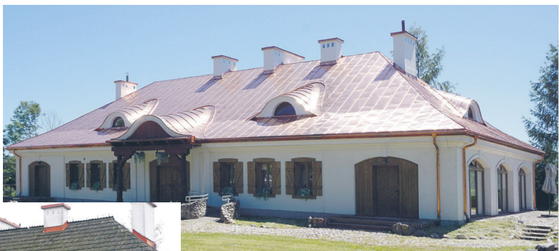
Zajazd po remoncie
