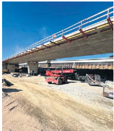
Nowy węzeł drogowy ma być gotowy jesienią przyszłego roku
