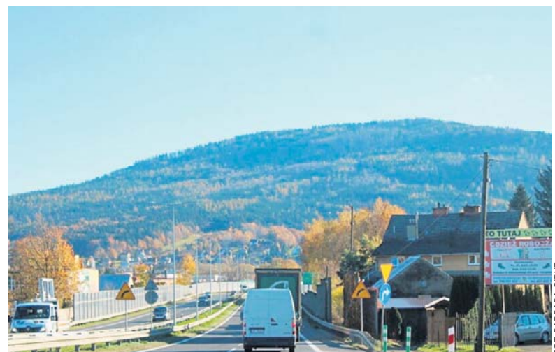
Trwa przebudowa zakopianki. Na odcinku Głogoczów-Myślenice powstaną nowe odcinki dróg lokalnych
