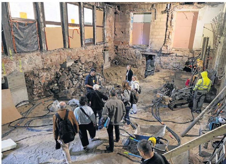
Pałac z zewnątrz nie zdradza ogromu prac w obrębie jego murów
