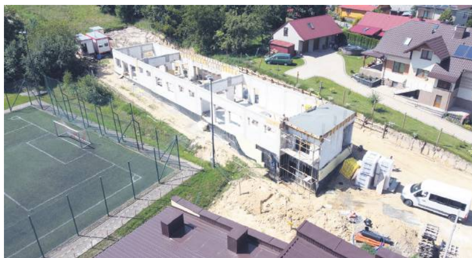
Budynek przeznaczony będzie dla 40 maluchów.
