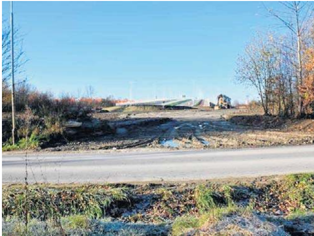
W tym miejscu powstanie rondo łączące ul. Sikorskiego i Andersa
