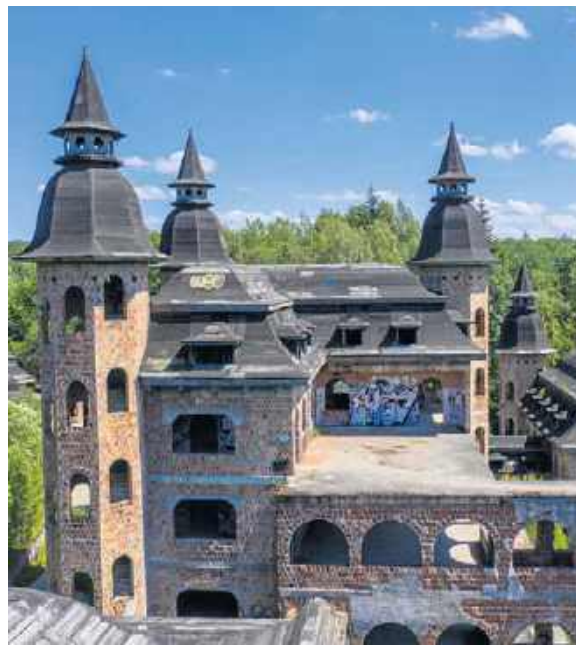
Zamek w Łapalicach - potężna ruina
