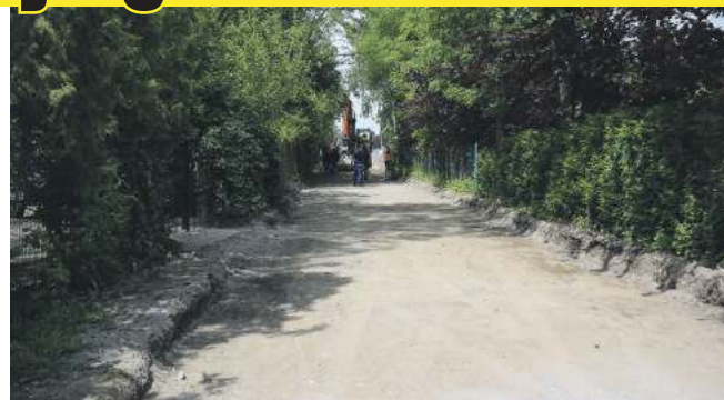
Ulica Słoneczna w Rogożu została wykorytowana i obecnie wykonywana jest podbudowa
