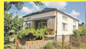
Dom o powierzchni 150 m 2 , w Białej Podlaskiej przy ulicy Prusa, powierzchnia działki 719 m 2 , 885 851 172
