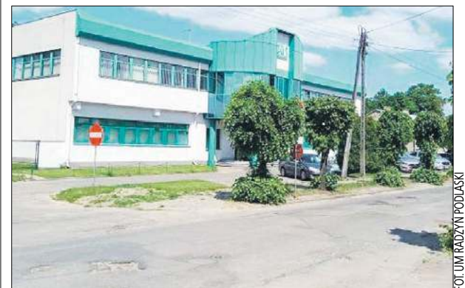
Jest przetarg na modernizację ul. Armii Krajowej. Będzie nowa nawierzchnia i chodniki
