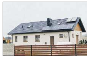
Gmina Piszczac kończy realizację dużego projektu OZE. 350 gospodarstw domowych zostało wyposażonych w instalacje fotowoltaiczne
