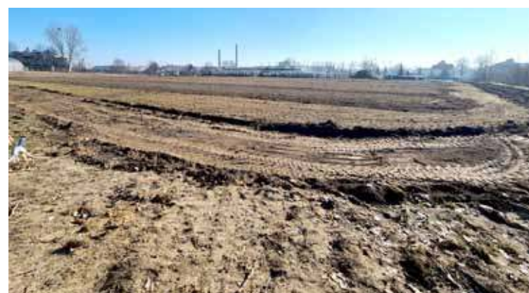
Umowa obejmuje również wykonanie systemu nawadniania oraz montaż instalacji zraszania płyty boiska
