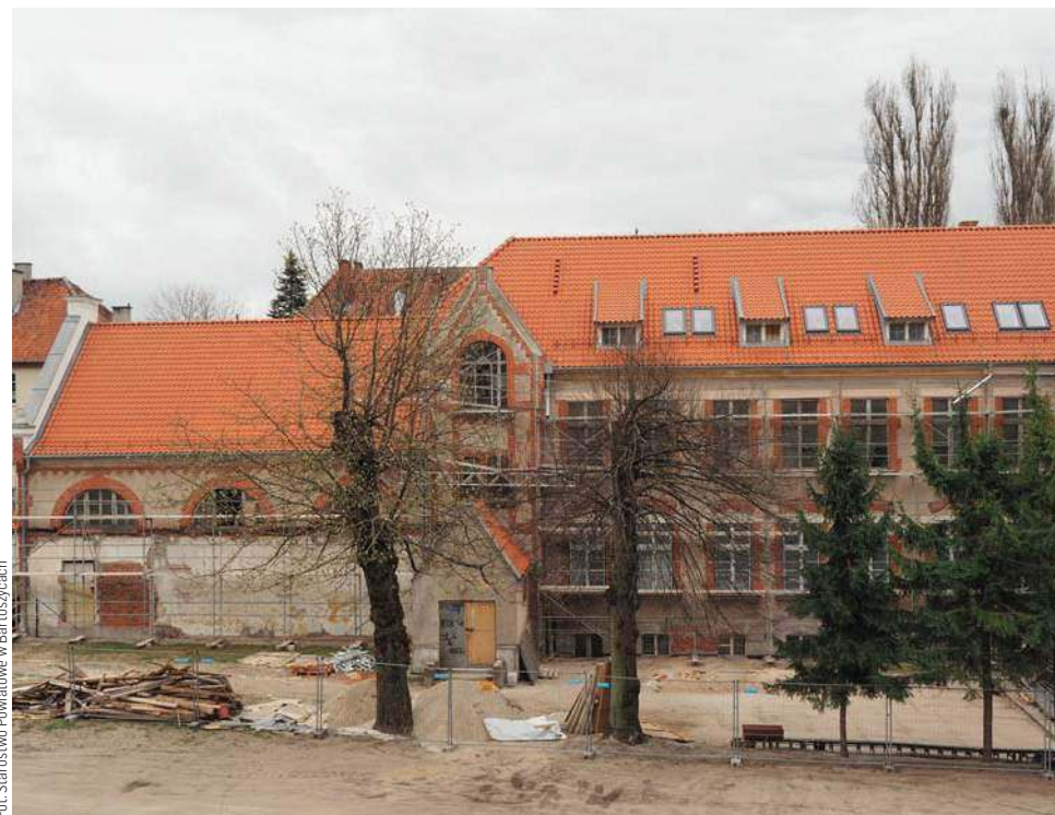
Trwają prace remontowe budynku przy ulicy Lipowej w Bartoszycach
