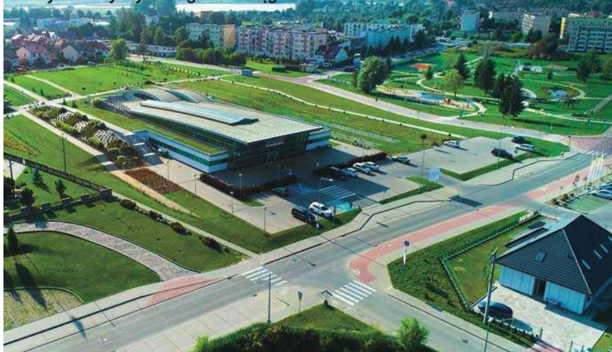
Pływalnia „Morąska Perła” oraz kompleks sportowo - rekreacyjny przy ulicy Kardynała Wyszyńskiego w Morągu
